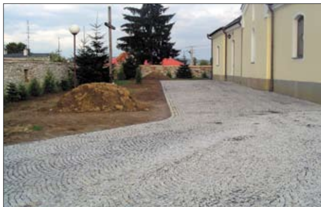
Układanie kostki brukowej na dziedzińcu kościoła
