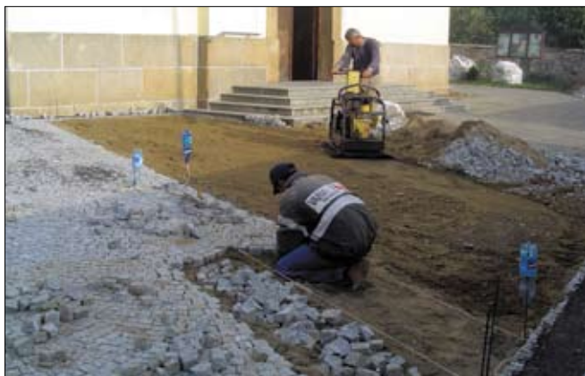
Układanie kostki brukowej na dziedzińcu kościoła
